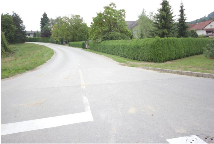
Slika 2: Odsek v Migojnicah brez pločnika
