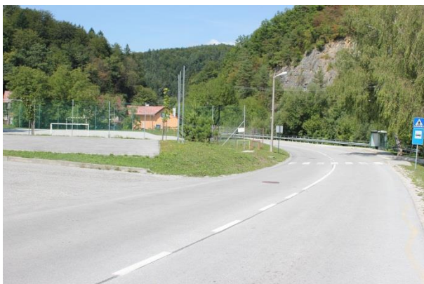
Slika 14: Prehod pri POŠ Liboje
