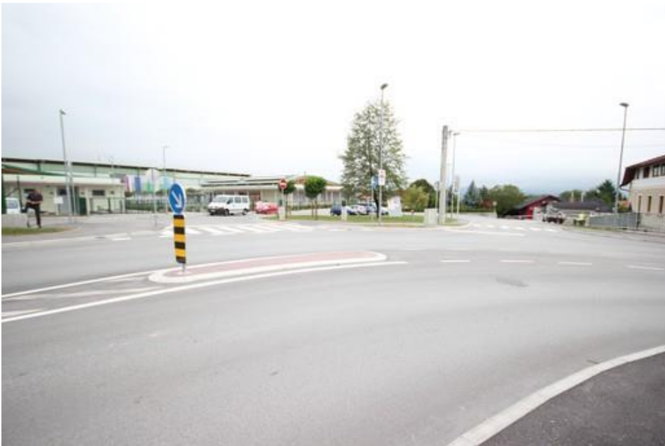
Slika 9: Križišče pri šoli (upoštevajo talne oznake)
