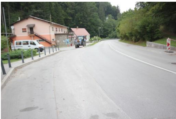
Slika 20: Pogled na cestišče pri trgovini v Libojah
