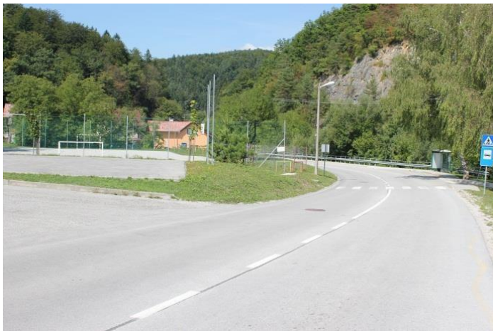
Slika 14: Prehod pri POŠ Liboje
