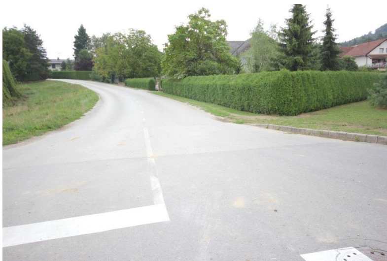
Slika 3: Odsek v Migojnicah brez pločnika
