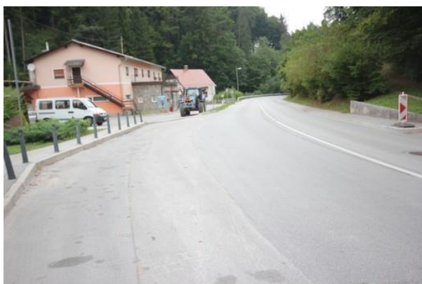
Slika 28: Pogled na cestišče pri trgovini v Libojah
