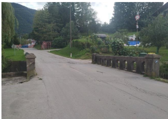
Slika 21: Zoženje ceste na mostu čez Artišnico
